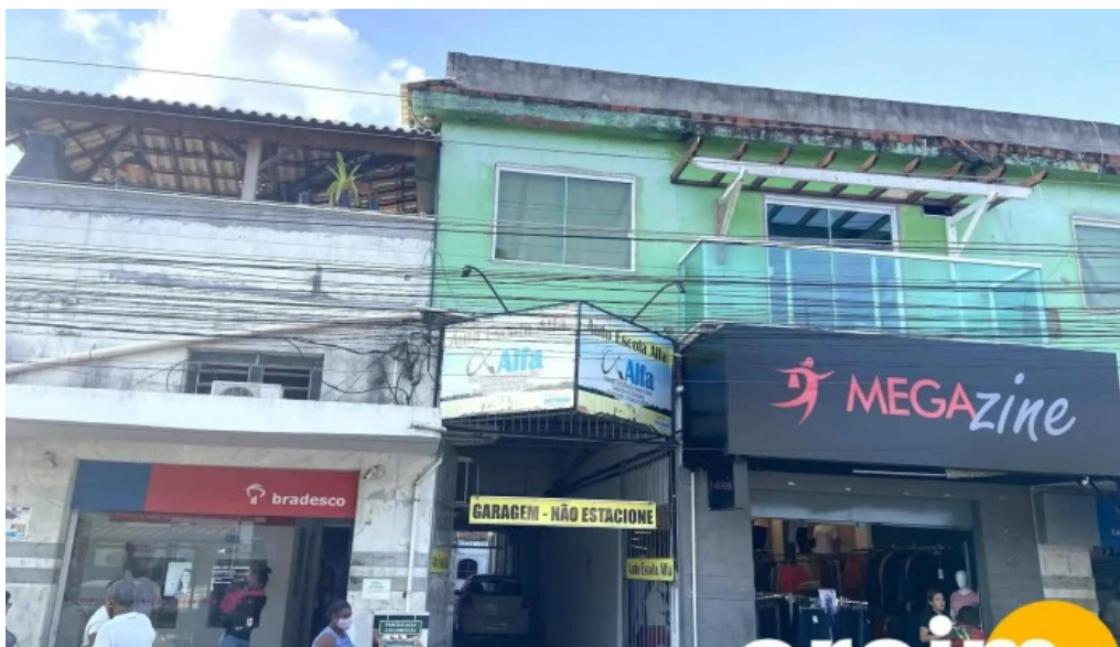
Auto escola alfa edificio
