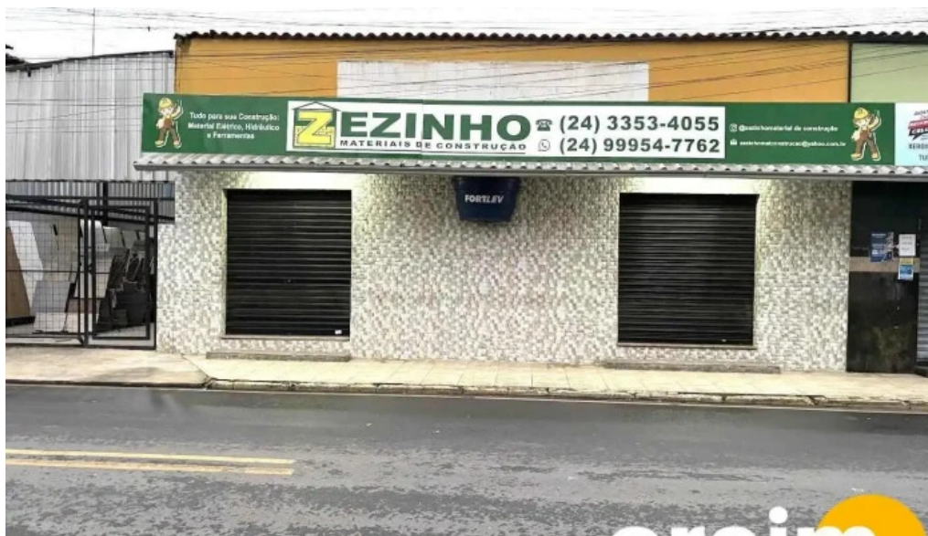
Zezinho materiais de construcao porto real
