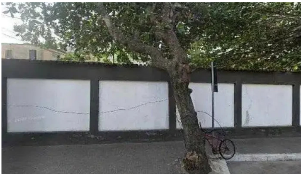
Galeria centro comercial do cabo street view e 360deg
